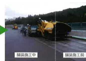
④舗装の施工
