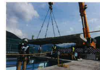
①コンクリート床版の撤去
