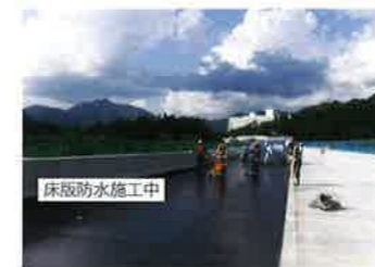
③床版防水の施工
