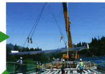
②新設プレキャストコンクリート床版の設置
